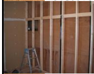
断熱材を入れる前
